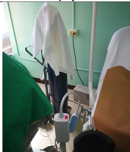
Foto 21 – Oxido nitros sin sistema de fijación en pared y debe ser movido para realizar procedimientos.
