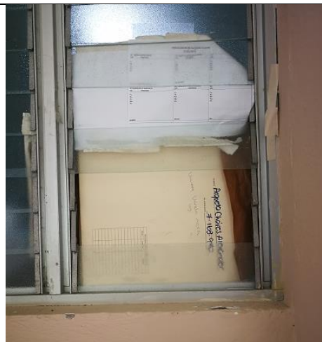
Foto 40 – Ventana que da en pasillo ginecología urgencias.
