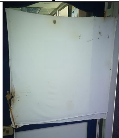
Foto 41 – Puerta de plataformas con cortinas.
