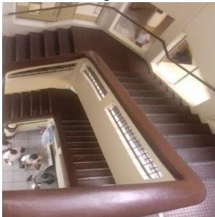
Escalera vista interna
