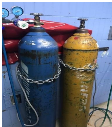
Foto 8. Cilindros herrumbrados en Sala
