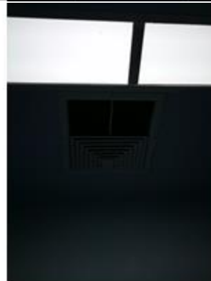
Foto 27 – Ductos de ventilator abiertos
