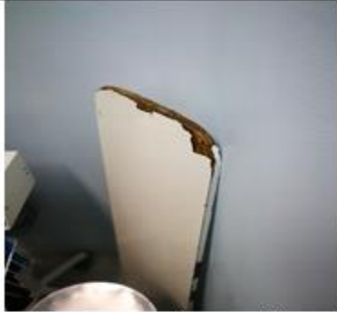
Foto 7 – Tabla dañada en quirófano
