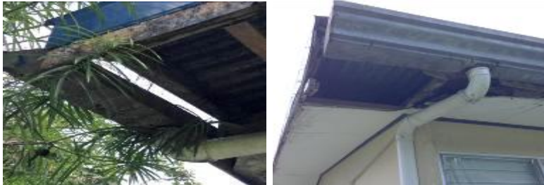
Desprendimientos de piezas en cielo raso.
