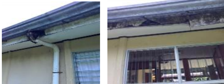
Desprendimientos de piezas en cielo raso.
