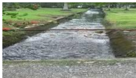
Caño desagua directamente al mar
