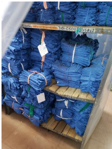
Ilustración 11. Bodega Satélite Nutrición. Los estantes no están sujetos al suelo o paredes con tornillos de alta resistencia.
