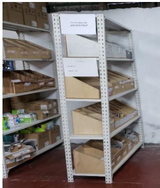
Ilustración 7. Bodega S.A.D. Materiales de Construcción. Los estantes no están sujetos al suelo o paredes con tornillos de alta resistencia.
