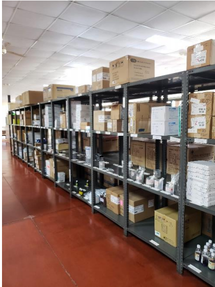
Ilustración 5. Bodega S.A.D. Efectivo y No Efectivo. Los estantes no están sujetos al suelo o paredes con tornillos de alta resistencia.
