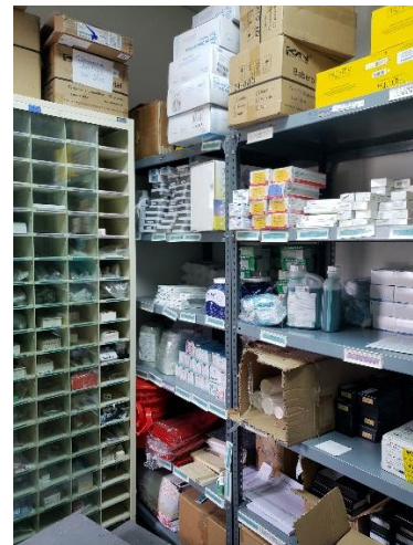
Ilustración 12. Bodega Satélite Odontología. Los estantes no están sujetos al suelo o paredes con tornillos de alta resistencia.
