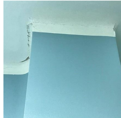
Foto 14. Columnas dañadas
