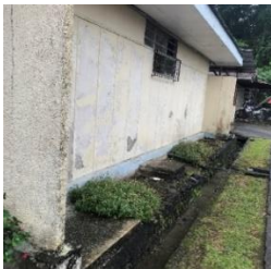
Imagen #13: Pared exterior
