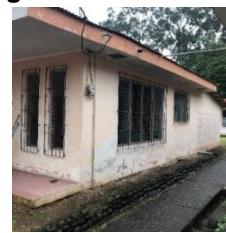
Imagen #12: Pared exterior
