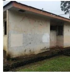
Imagen #10: Pared exterior
