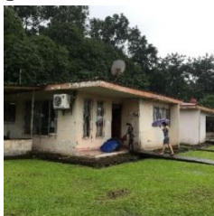
Imagen #15: Pared exterior
