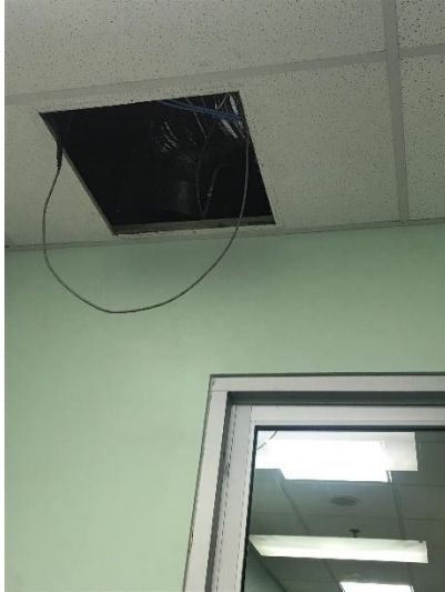
Fotografía 13: ducto del aire acondicionado, área despacho
