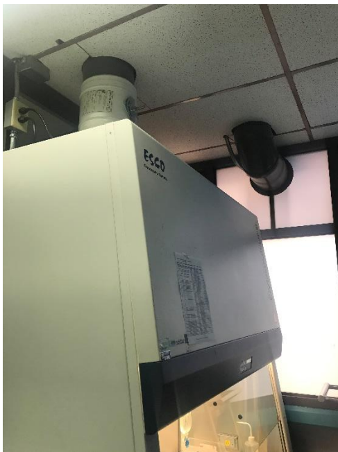
Fotografía 19: ducto de aire de la cámara de flujo laminar
