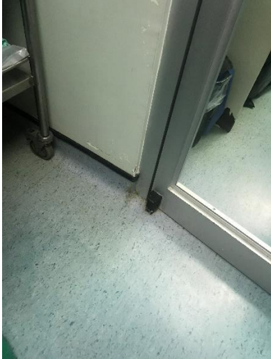
Fotografía 1: paredes y pisos del área gris
