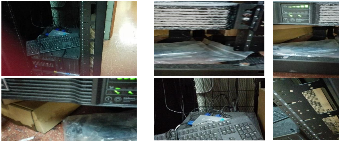
Imagen No. 12 Inspección física del CGI del Hospital de San Carlos
