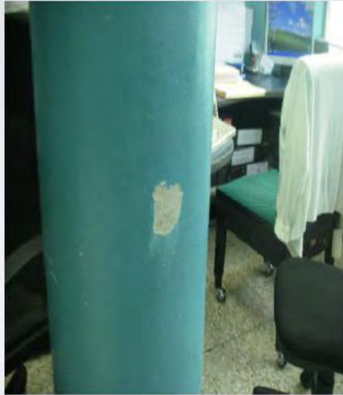
Pruebas no destructivas de materiales
