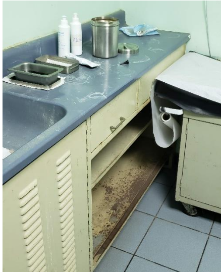
Ilustración 17. Mueble con herrumbre. Consultorio 2 enfermería.
