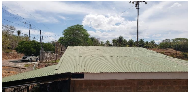
Ilustración 34. Accesos bajo láminas de techo.
