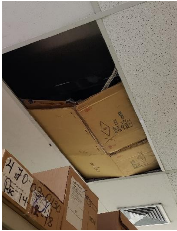
Ilustración 5. Cielo raso sin lámina. Bodega de Bienes y servicios.
