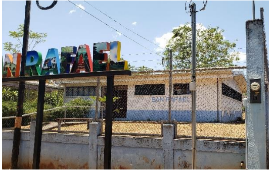
Ilustración 19. Deterioro de pintura de muro y exteriores.
