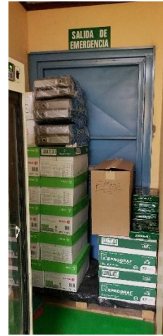
Ilustración 6. Puerta de Emergencia obstruida. Bodega Bienes y servicios.
