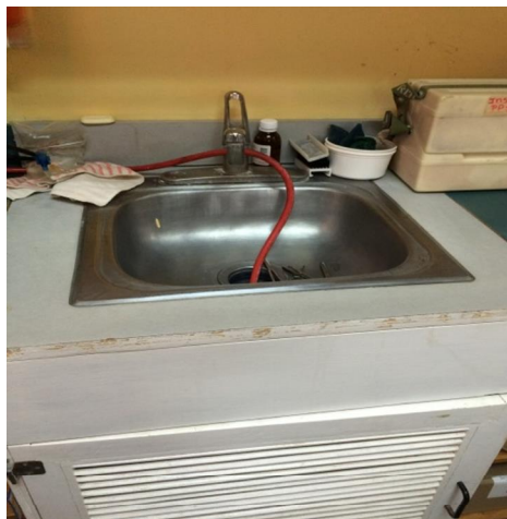
Fotografía 9, Lavatorio Servicio de Enfermería.
