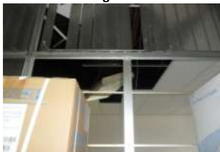
Ventanales sin vidrios
