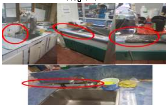
Piletas de Laboratorio clínico (bloque A)
