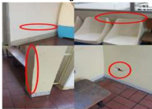
Condiciones en las paredes.
