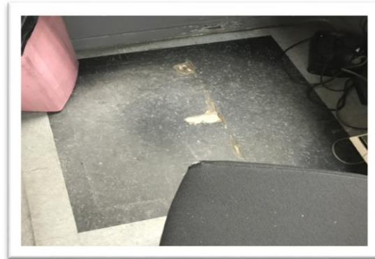
Fotografía 2 Huecos en el piso de cubículo en la Subárea Caja y Custodia de Valores
