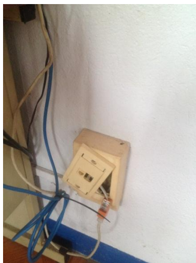
Fotografía 3: Punto de red dañado
