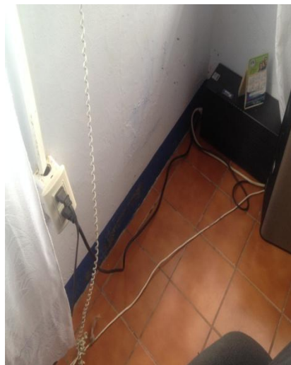
Fotografía 4: Cables en el piso sin protección
