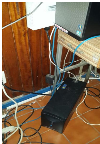
Fotografía 4: Cables en el piso sin protección
