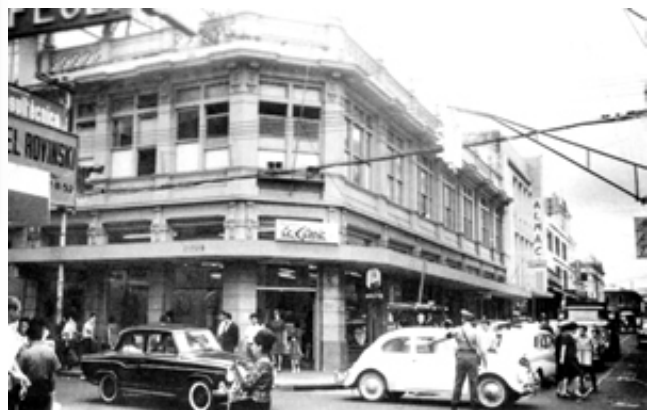
Las oficinas centrales de la CCSS estuvieron ubicadas en Avenida Central, calle 2, esquina opuesta al Banco Central, en San José.
