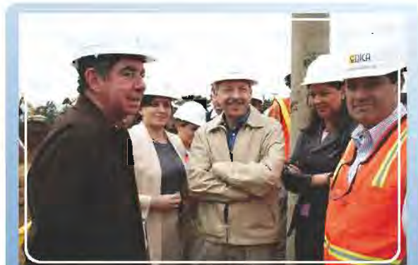
El Presidente de la República, Dr. Óscar Arias Sánchez, visitó la construcción del nuevo hospital de Heredia junto a las autoridades de la CCSS, para ser testigo del avance de las obras.
