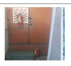
• Taller de mantenimiento: № de extintores asignados 3 tipo polvo químico, el indicador de presión -manómetro- no se encontraba en un rango operable.
