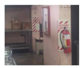
• **Servicio de Lavandería**: Nº de extintores asignados 4 tipo CO2 y agua tridestilada, el indicador de presión -manómetro- no se encontraba en un rango operable.
